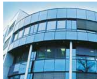
Byk Chemie, Wesel Architect: Architecture office M. Kleinböhrer & Partner, Hamminkeln Specialist consultant: Ingenieurgesellschaft Meinhardt Fulst GmbH Construction company: J. Christoffers GmbH & Co. KG
