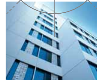
Feldbergstraße, Frankfurt/Main Architect: Collignon Gesellschaft von Architekten mbH, Berlin Specialist consultant: Integ Prof. Mayer & Partner
