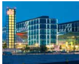
Main Train Station, Berlin Architect: gmp von Gerkan, Marg and Partners, Hamburg Construction company: Eichelberger GmbH & Co. KG – Airteam Lufttechnische Anlagen GmbH
